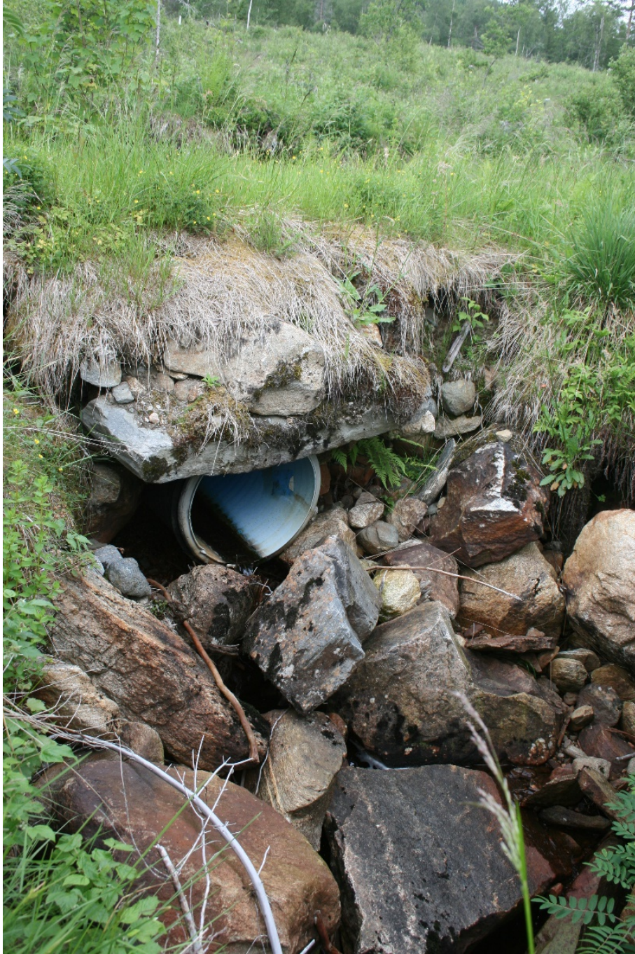
Stikkrenne med innlagt rør. Foto: Siw Helen Myrvoll Grønland
