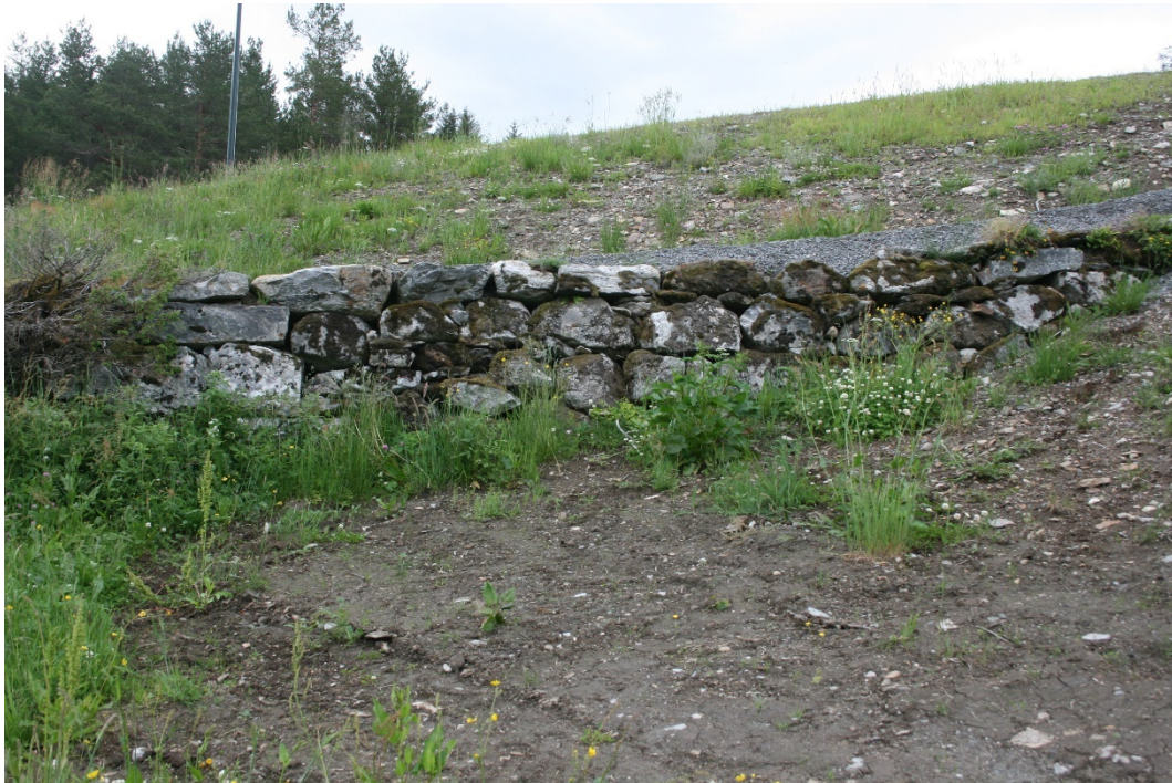
Støttemur ved Amdam. Foto: Siw Helen Myrvoll Grønland
