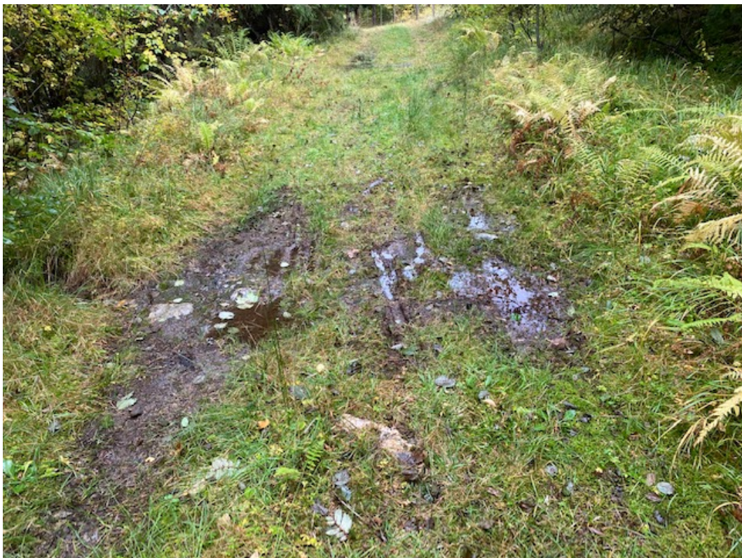
Fordypninger med vannansamling på veien. Foto: Siw Helen Myrvoll Grønland
