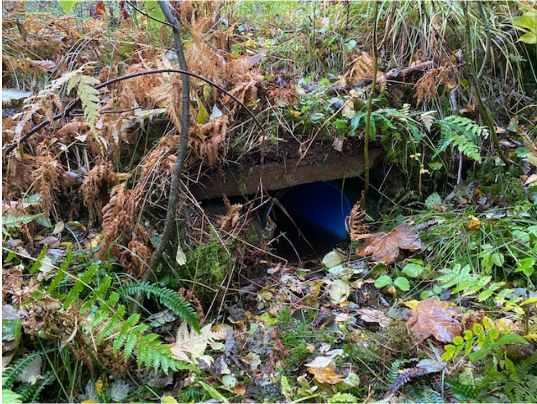
Stikkrenne med steinhelle og plastrør. Foto: Siw Helen Myrvoll Grønland
