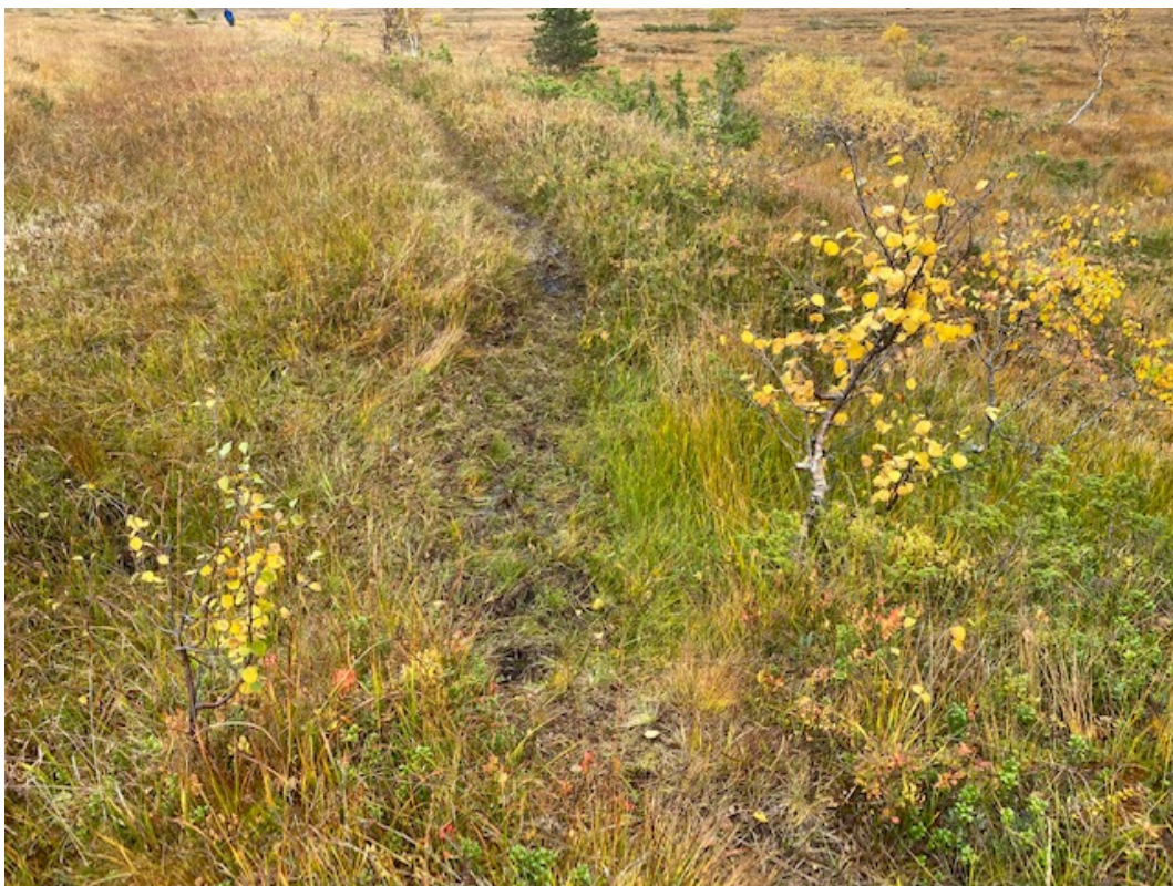
Veibanen er gjennomtrukket av vann. Foto: Siw Helen Myrvoll Grønland
