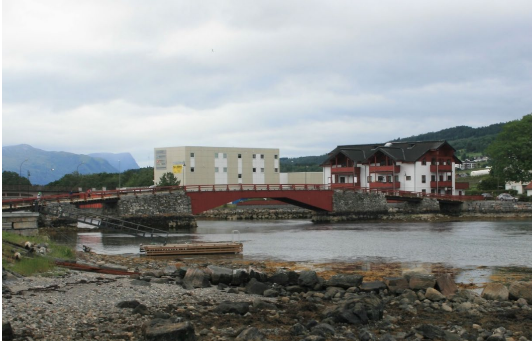
Bjelke- og sprengverksbru i parsell 4, Vestnes sentrum. Foto: Siw Helen Myrvoll Grønland
