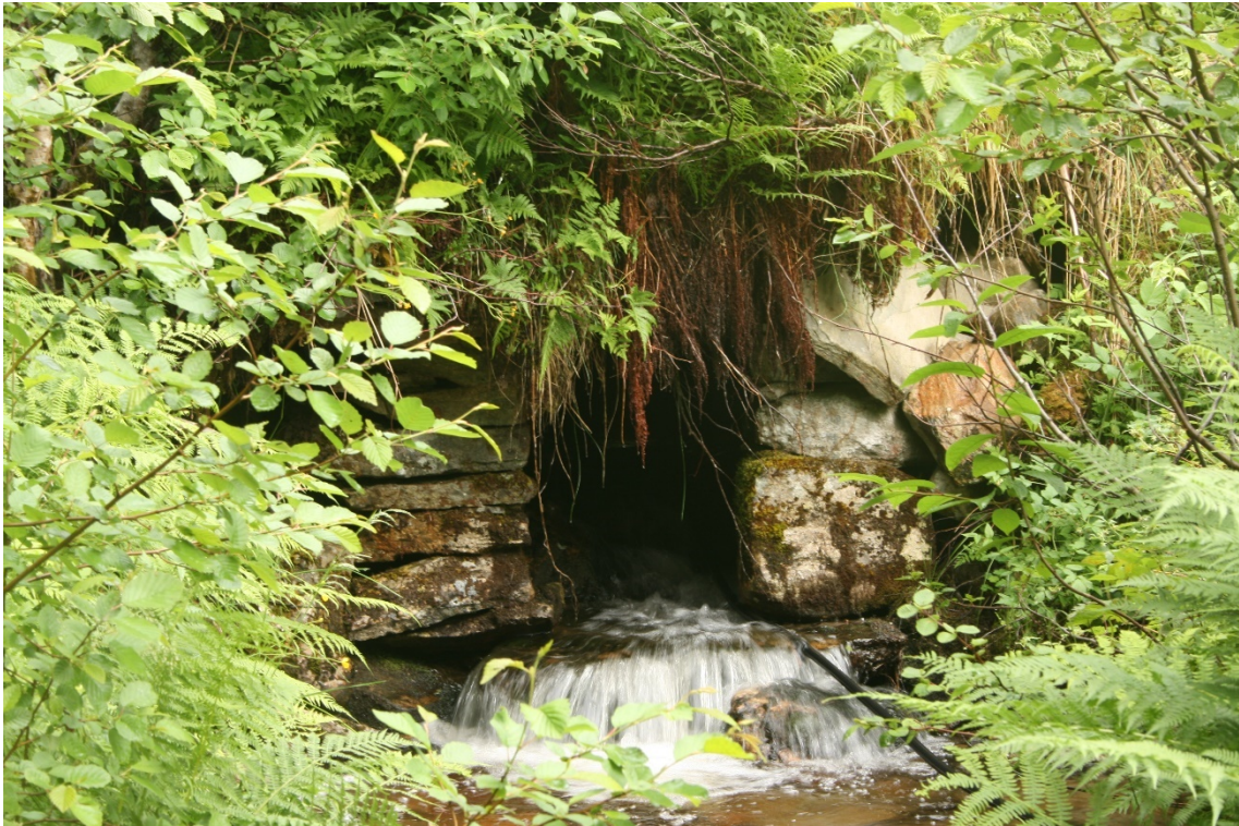
Et eksempel på stikkrenne oppbygd av steinheller. Ligger i parsell 2, Vestnes. Foto: Siw Helen Myrvoll Grønland
