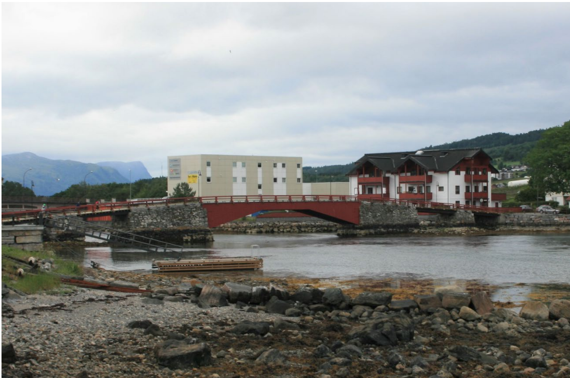
Bildet viser et eksempel på bru med nyere brudekke i tre på parsell 4 i Vestnes sentrum. Foto: Siw Helen Myrvoll Grønland
