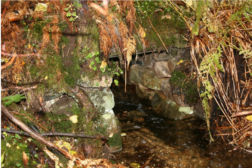
Bilde 10 Liten steinhellebru/stikkrenne med behov for generelt skjøtselsarbeid like ved Bølsetvoren. Foto: Siw Helen Myrvoll Grønland
