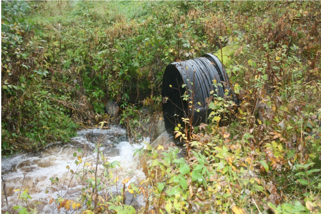
Plastrør i bruas løp. Mose og lavtvoksende vegetasjon rundt løpet. Krever ikke tiltak per 2019. Foto: Siw Helen Myrvoll Grønland
