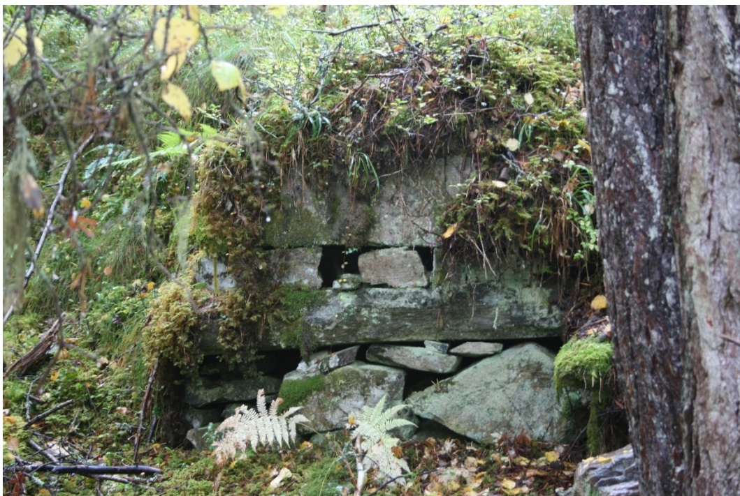
Bilde 8 Steinfundament under veien som hører til brua. Foto: Siw Helen Myrvoll Grønland
