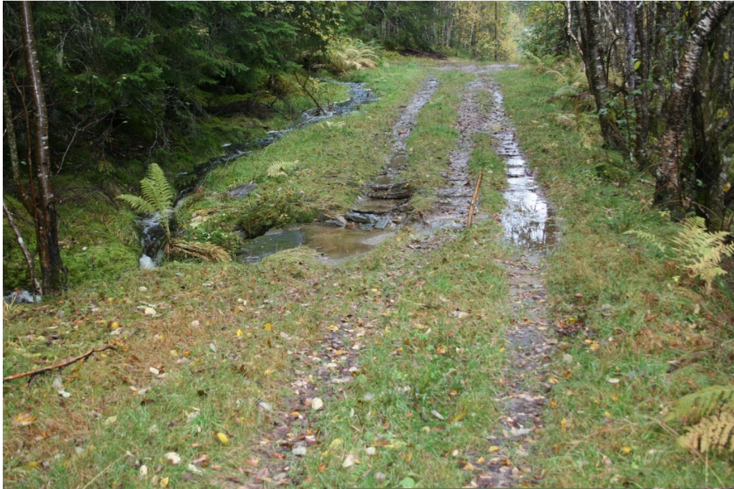
Bilde 4 viser vann som samler seg i groper i veien. Vil vaske bort sanden over tid og hullene bli dypere. Foto: Siw Helen Myrvoll Grønland
