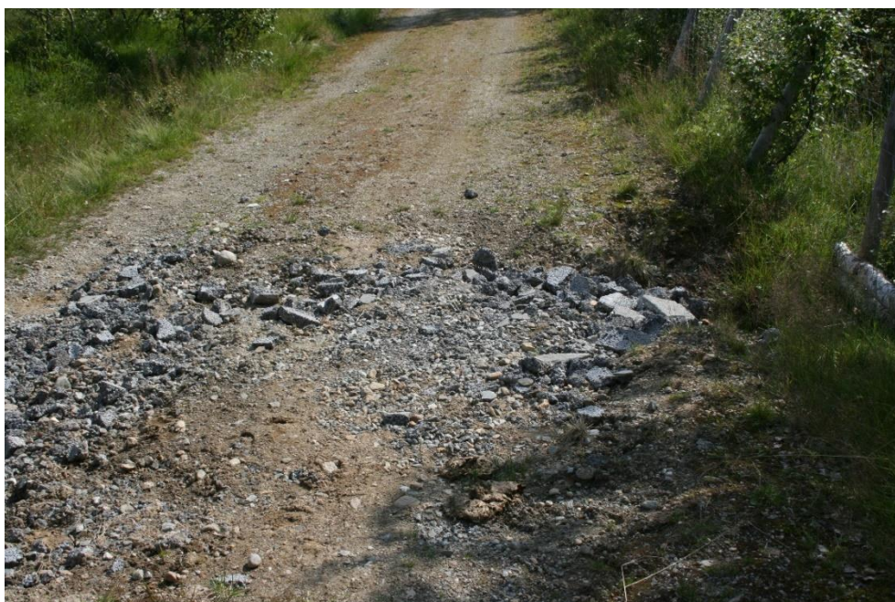
Veidekket over stikkrenne oppfylt med Lecastein.
