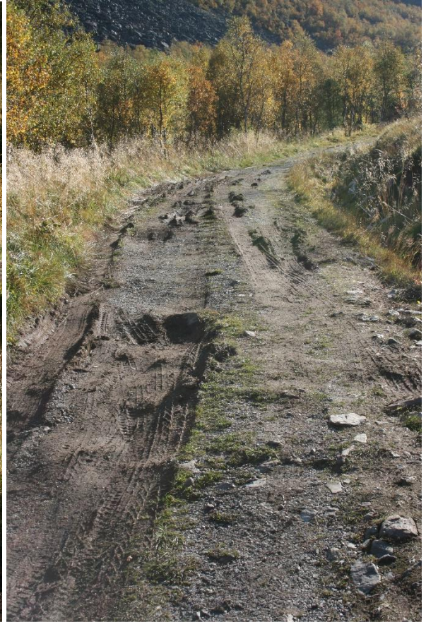
Stygt skadet vei i svingene ovenfor tunnelen. Foto: Siw Helen Myrvoll Grønland
