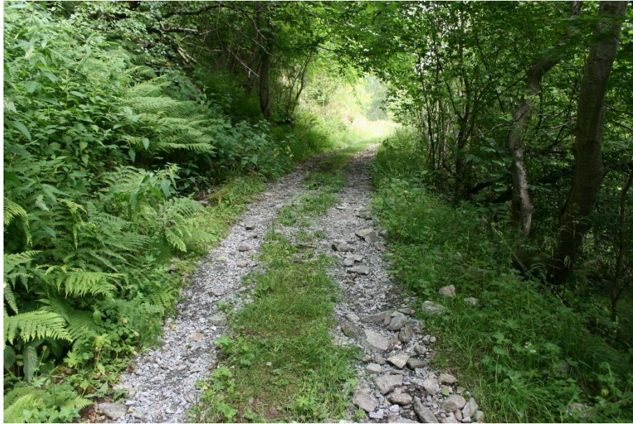
De løse steinene gir ikke en god opplevelsesverdi av veien som historisk vanderrute. Foto: Siw Helen Myrvoll Grønland
