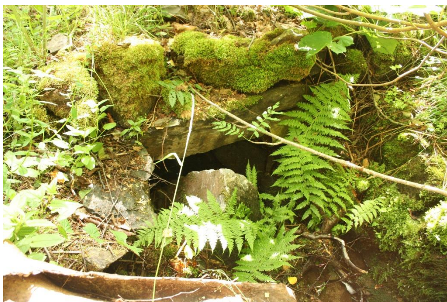
Stikkrenne med stor stein i løpet. Foto: Siw Helen Myrvoll Grønland
