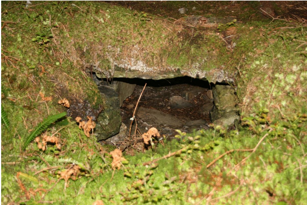
Et eksempel på stikkrenne oppbygd av steinheller. Foto: Siw Helen Myrvoll Grønland
