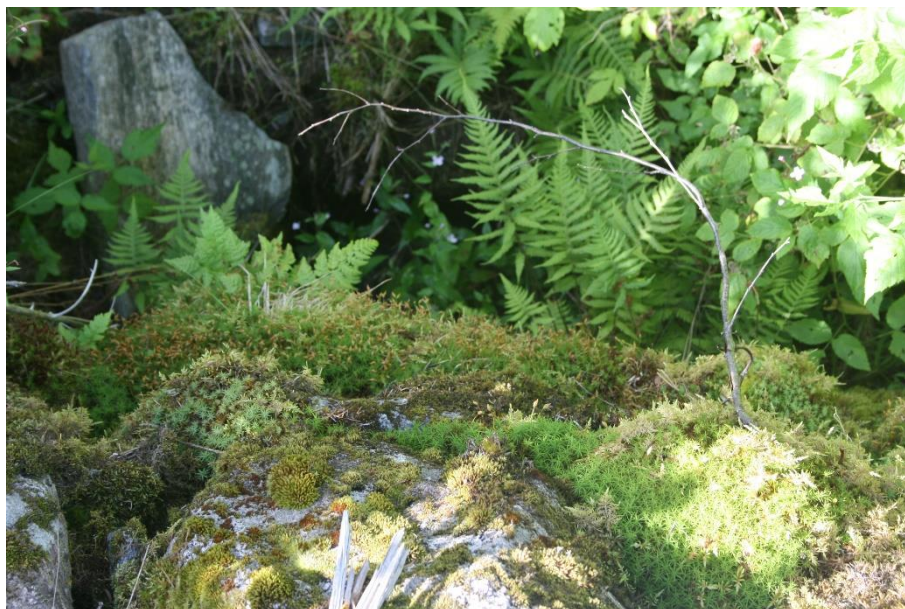
Støttemur sett ovenfra. Foto: Siw Helen Myrvoll Grønland
