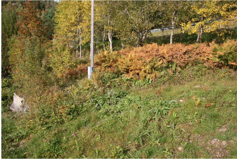
Vegetasjonen kan skjule skader. Foto: Siw Helen Myrvoll Grønland
