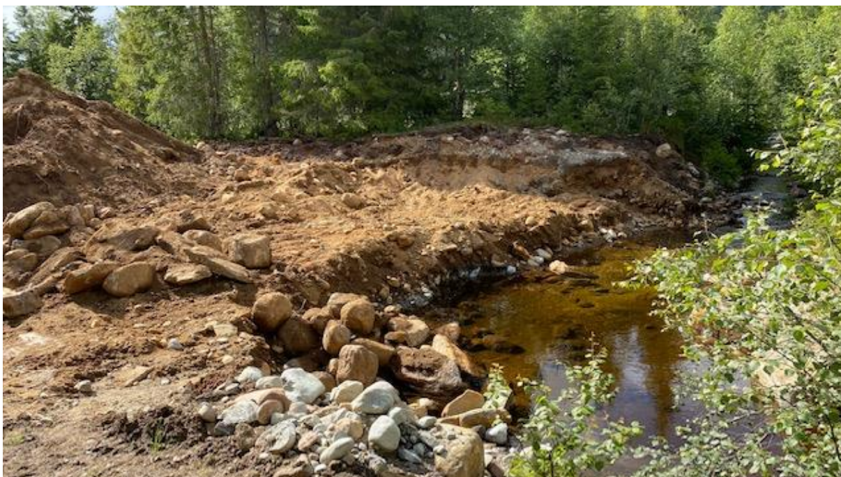
Oppgravd område forringer opplevelsesverdien av veien. Foto: Siw Helen Myrvoll Grønland
