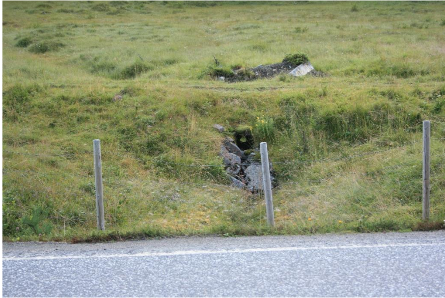
Moderne oppfylling med stikkrenne? Foto: Siw Helen Myrvoll Grønland
