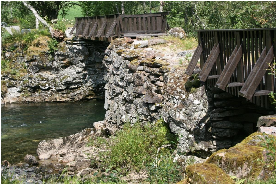
Bildet viser et eksempel på bru med nyere brudekke i tre på parsell 2. Foto: Siw Helen Myrvoll Grønland
