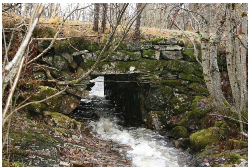
Steinhellebrua på Sollia har sig i fundamentet.
