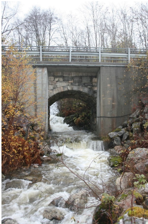
Hvelvbru fra 1913 og utvidet med moderne betongfundamenter. En del av et veihistorisk miljø. Foto: Siw Helen Myrvoll Grønland
