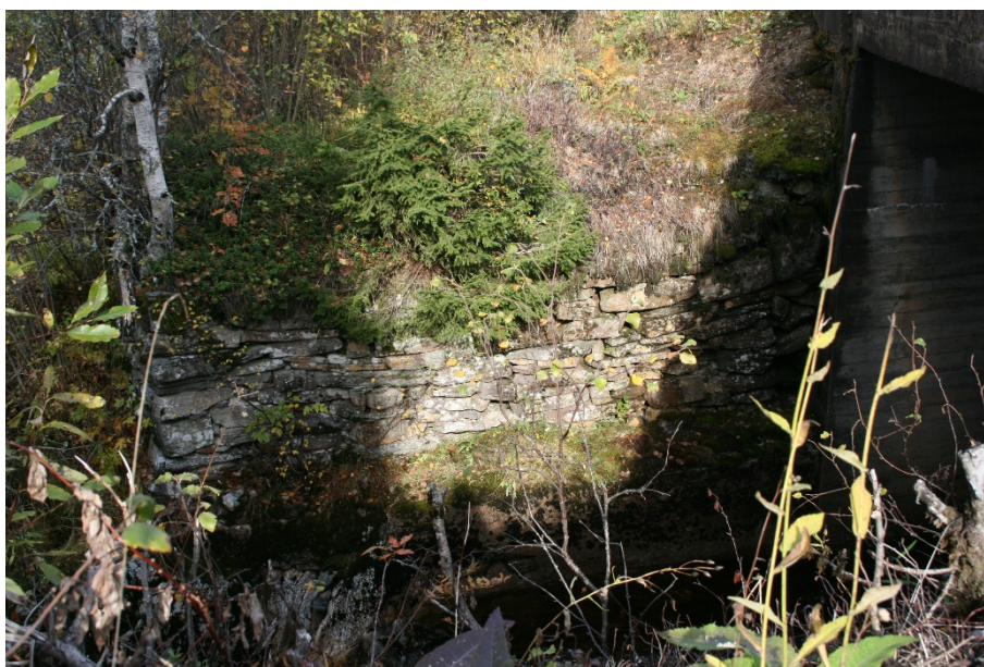
Brufundament i steinheller. Foto: Siw Helen Myrvoll Grønland
